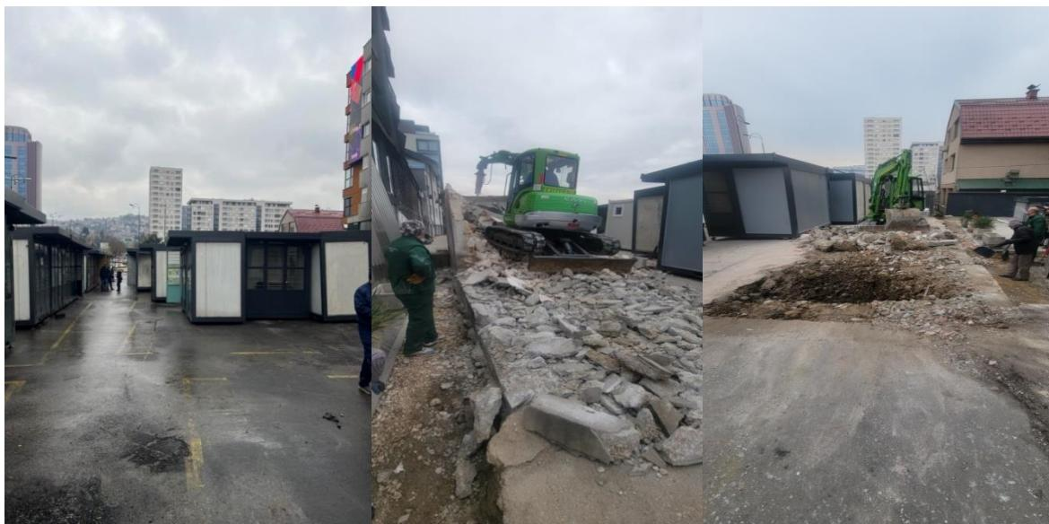
Izvršeno je uklanjanje postojećeg zidanog WC i postavljanje novog, a sve iz razloga ostavljanja mesta za protivpožarni put između susjednih objekata i naših kioska. Također je izvršeno i prikopčavanje wc-a na vodovodnu i kanalizacionu mrežu.
