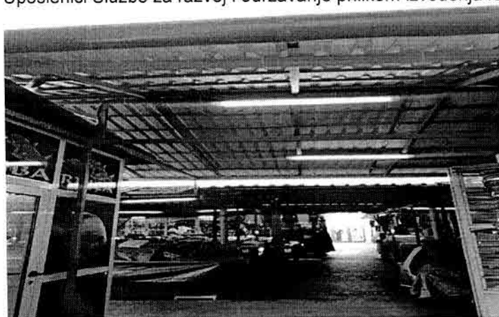
Krovna konstrukcija na „Pijaci Ilidža”
