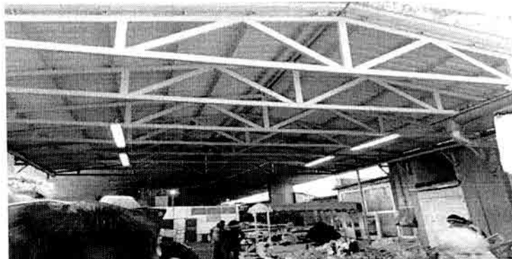
Izgled krovne konstrukcije nakon završetka radova na Pijaci "Koševo"
