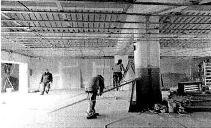
Na pijaci „Alipašino polje“ u toku je rekonstrukcija i adaptacija poslovnog prostora
